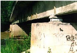
Abb. 28.2: Rollenlagerung einer Brücke
