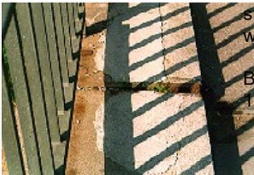
Abb. 28.1: Fuge einer Brücke
